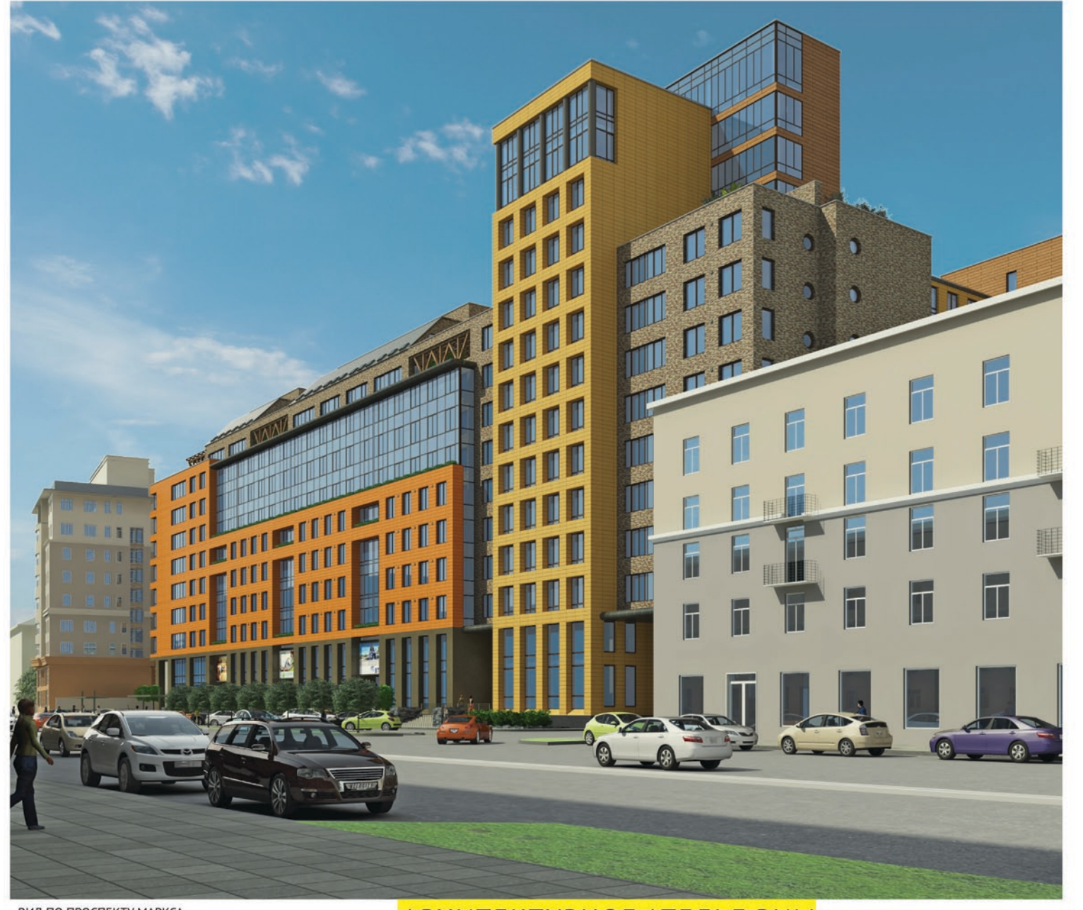
ВИД ПО ПРОСПЕКТУ МАРКСА
