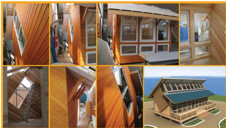
Рис 5. Сборка тестового домика Solar-5M на линии HUNDEGGER Технопарка ДВГТУ. Архитектор Павел Казанцев, сборка – инженер Владимир Стретенцев
