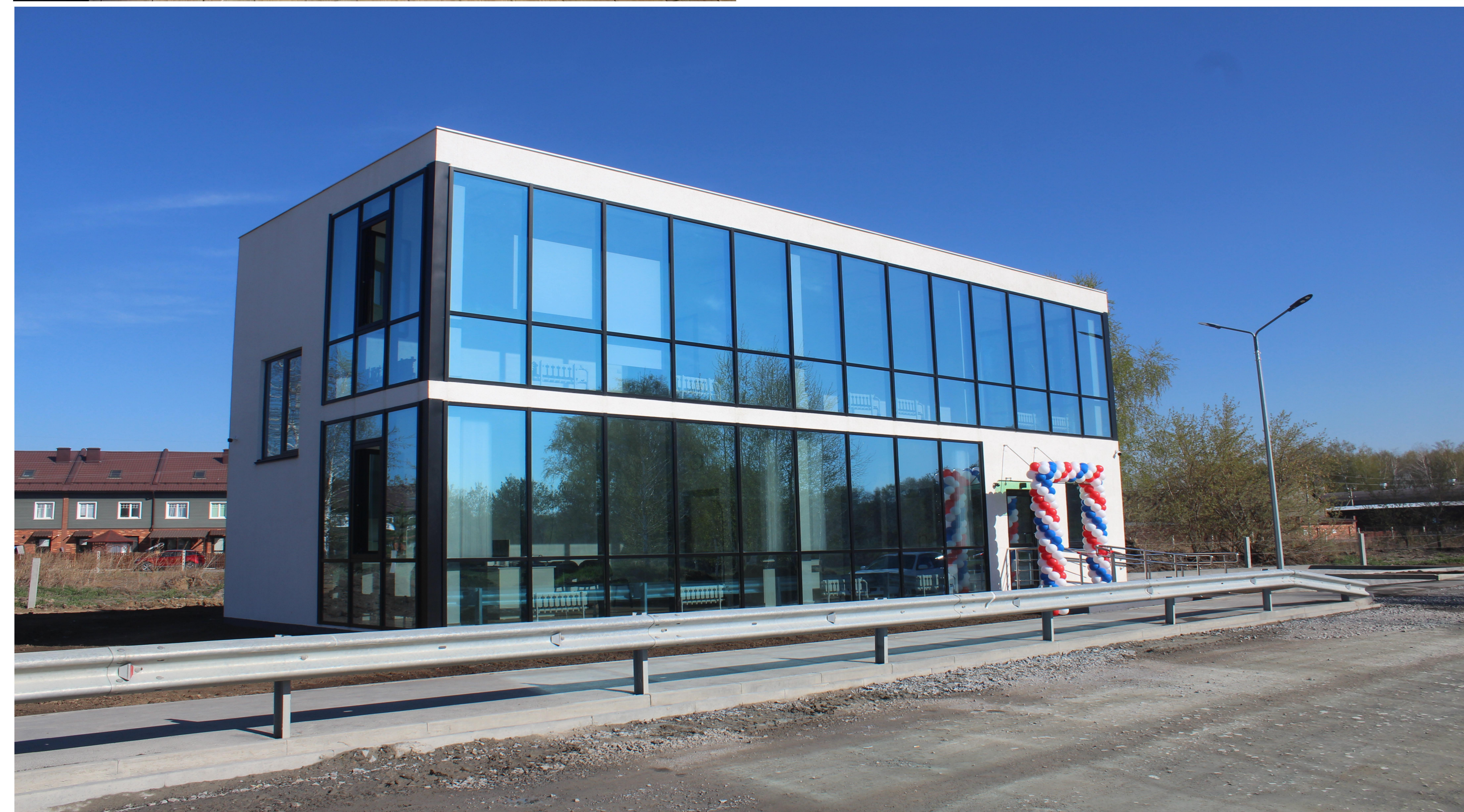
Современный участковый пункт полиции построен в микрорайоне «Пригородный простор» в селе Толмачево Новосибирской области. Помещение оборудовано всей необходимой для работы техникой. В здании предусмотрены рабочие места для двух участковых, инспектора по делам несовершеннолетних, а также комната видеонаблюдения для охраны микрорайона. Застройщик Потребительский кооператив «Содействие».
