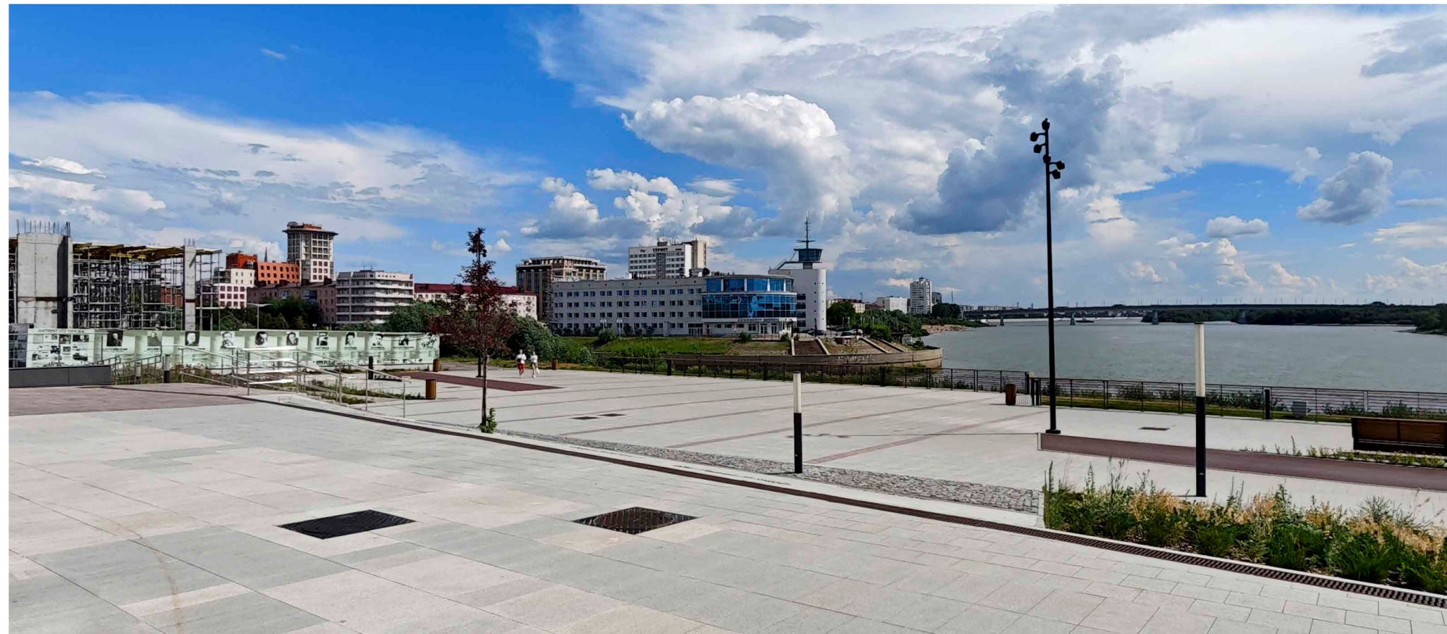
ВИД НА ПЛОЩАДЬ УСТЬ-ОМСКОГО ПОЛУБАСТИОНА. ФАКТУРНЫЙ ОТКОС ПОДЧЕРКИВАЕТ ГРАНИЦУ КРЕПОСТИ, КОНТУР ОБЗОРНЫХ ПЛОЩАДОК ИНТЕРПРЕТИРУЕТ ВЫСТУП УКРЕПЛЕНИЙ.
